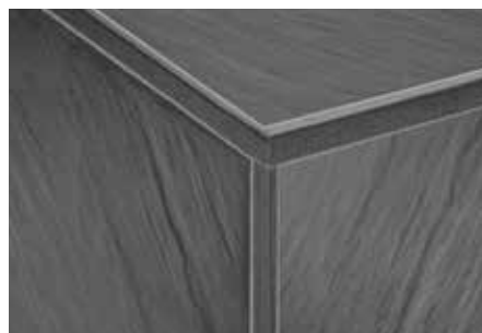
Réalisation d'angles avec coupe en onglet
