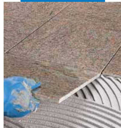
Pose de marbre poli en sol
