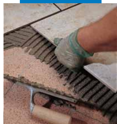
Pose de carrelage sur carrelage existant en sol intérieur
