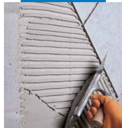
Pose de carreaux sur béton cellulaire
