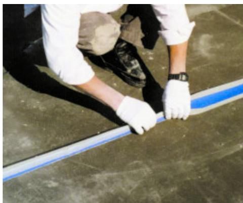
Exemple d'étanchéité d'un joint de dilatation sur une terrasse
