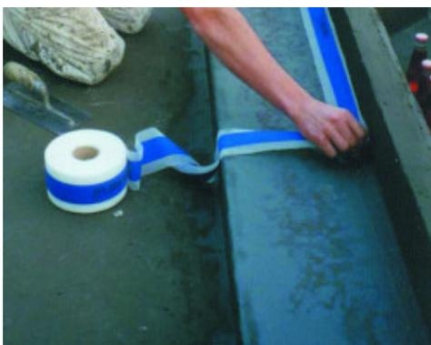
Imperméabilisation de la jonction entre le support et le bassin avec Mapeband.
